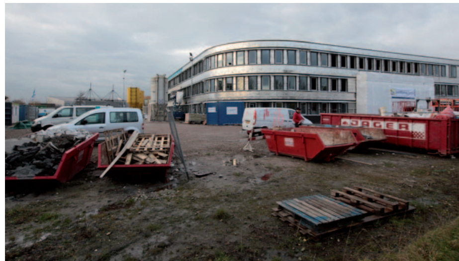
De contouren van het nieuwe schoolgebouw zijn inmiddels duidelijk zichtbaar. Naar alle waarschijnlijkheid kan ROC Friese Poort in juni 2012 gebruik maken van de nieuwbouw aan de Splitting.
